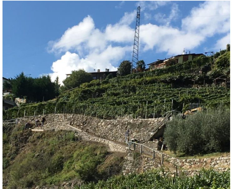
Un tratto di sentiero storico comunale di Arbulè con il rifacimento dei muri
